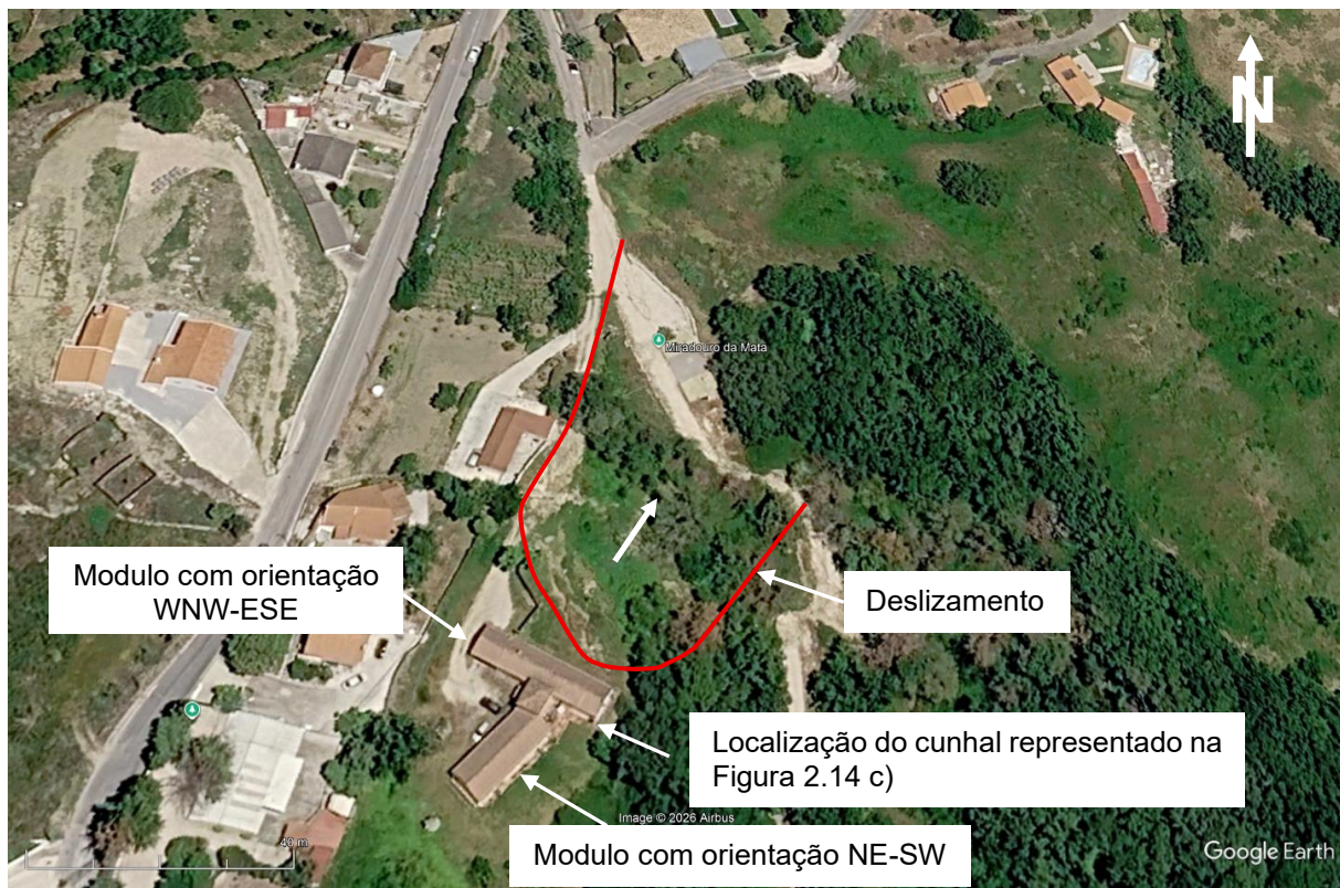
Figura 2.13 – Imagem Google de junho de 2026 da habitação situada em Mata, a linha vermelha representa o deslizamento ocorrido na área de logradouro situada a nordeste do modulo com orientação WNW-ESE e a seta branca o sentido do movimento
