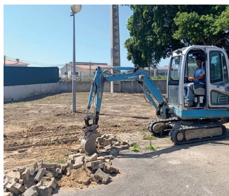
■ Obra no espaço verde do Solar das Cardosas
