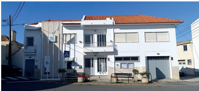
■ Pintura do edifício da Junta
