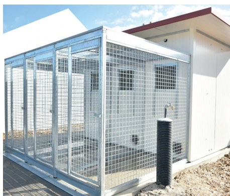
■ Edifício destinado a gatos
