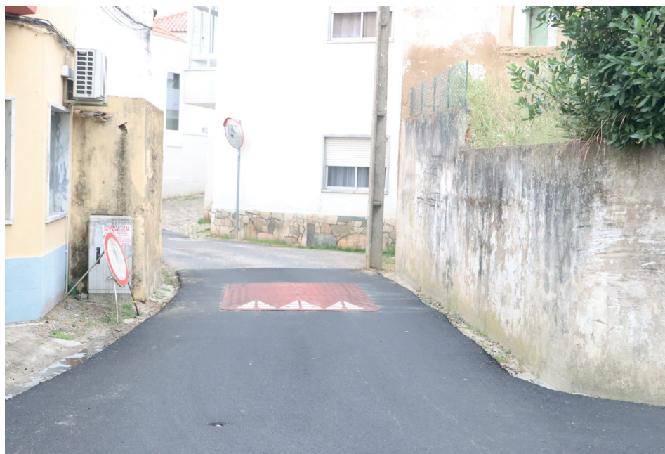
■ Instalação de almofadas redutoras de velocidade, Rua do Mel - Arruda dos Vinhos
