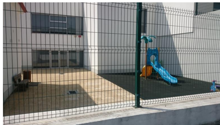
Fig. 9 - Vista zona do recreio do jardim-de-infância.
