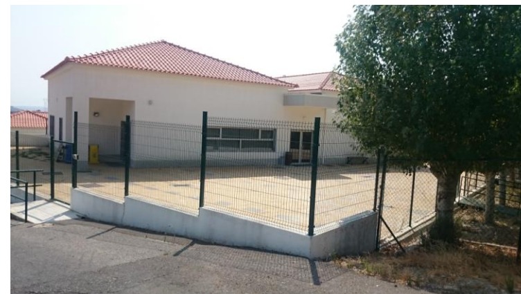
Fig. 8 - Vista da zona do recreio do 1º ciclo.
