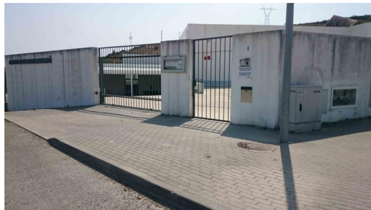
Fig. 1 - Vista dos muros de vedação.
