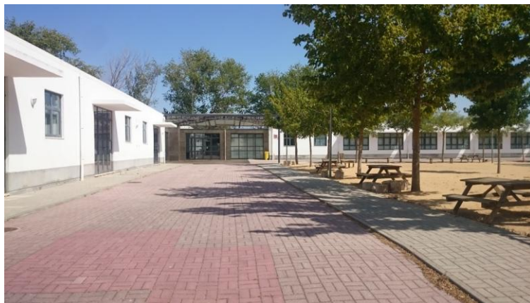
Fig. 4 - Vista geral do Centro Escolar.
